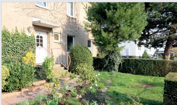
Sanierungsbedürftiges Einfamilienhaus in Bestlage Wolteritzer Weg, Leipzig/Eutritzsch
